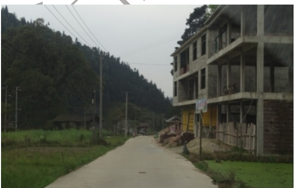
龙寨塘村段进场道路
