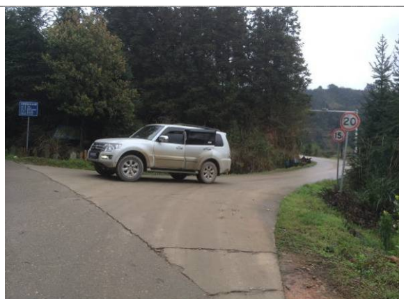
改建道路起点-拔湘
