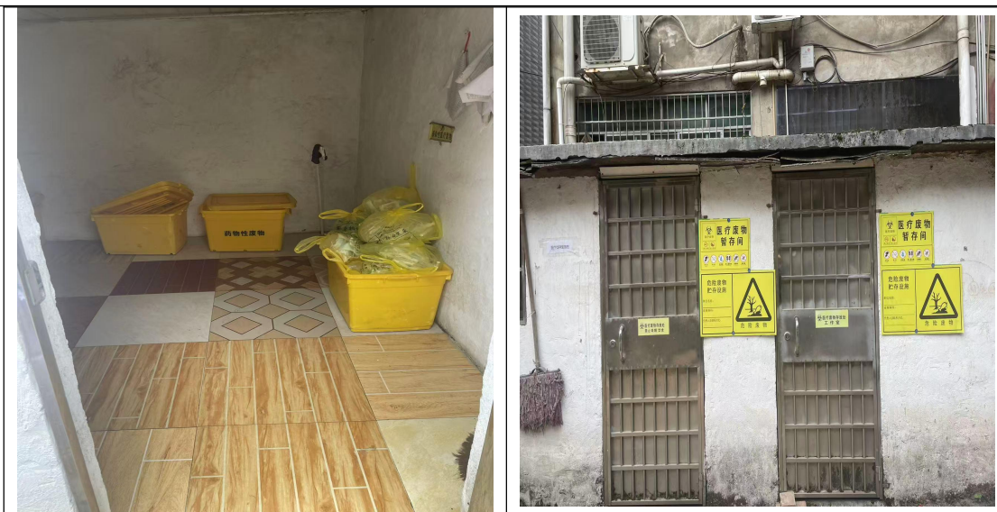
图 2-4 医疗废物暂存间现状图
